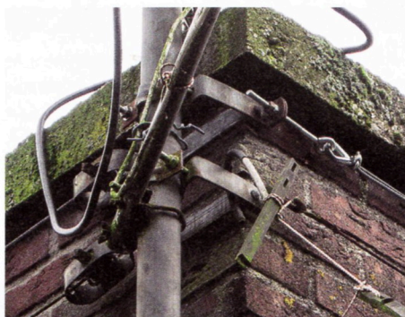
Afb. 22 De nieuwe staalkabel met oog en puntstuk
